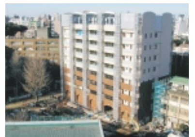
完成間近の総合研究棟1号館
